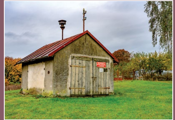
Dawna remiza w Zawadzie Ehemalige Feuerwache in Springberg
