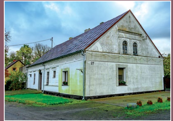
Dawny zajazd w Pokrzywnicy Altes Gasthaus in Krummfliess
