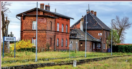
Dworzec kolejowy Skrzatusz Bahnhof in Schrotz
