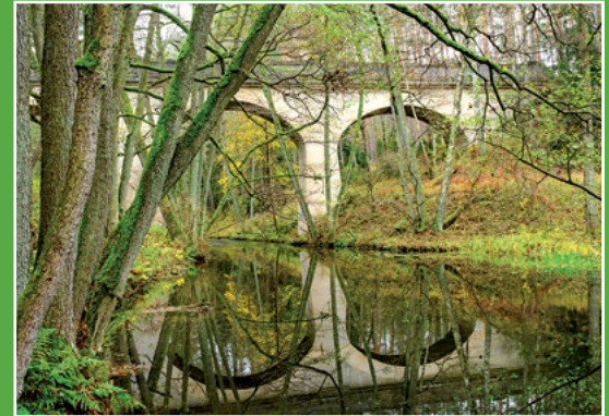
Most kolejowy na Rurzycy Eisenbahnbrücke auf der Rohra
