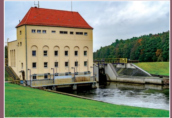
Elektrownia w Dobrzyca Elektrizitätswerk in Borkendorf
