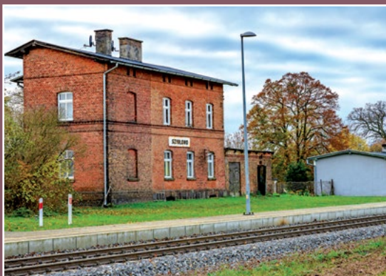
Dworzec kolejowy w Szydłowie Bahnhof in Groß Wittenberg
